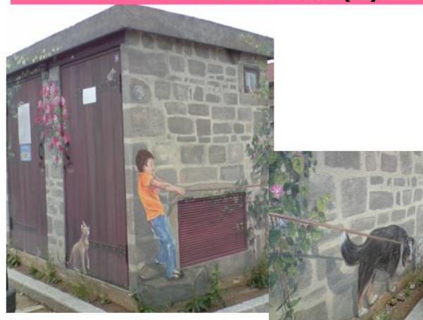
Faites le tour du transformateur transformé...
