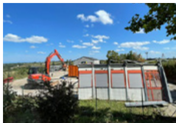
Démolition des préfabriqués en vue d'une construction d'un bâtiment moderne.
